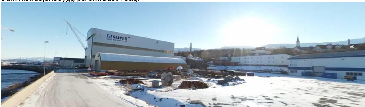
Figur 1: Dagens situasjon ved Slipen Mekaniske AS. Eksisterende hall er en beddinghall med en innebygd slip der båtene dras inn fra sjøen. Kilde: Google gatebilder.
